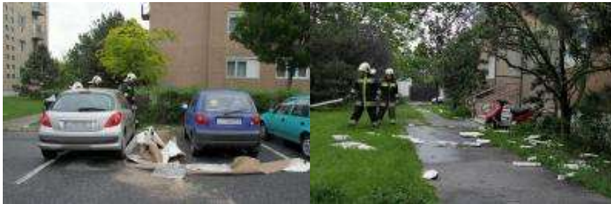
Székesfehérvári viharok 2014. május: egy lakóház szigetelésének sérülése
